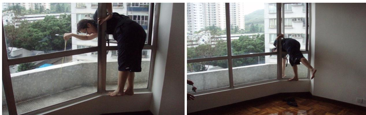
部份的花槽原設計闊度有 575 mm 及 3600mm 的長度(Girth) (如下圖所示)，從 1,100 mm 高的窗前室內，根本無法打理該花槽，除非攀過窗口。
