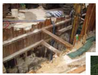
總污水渠接駁工程 2011
