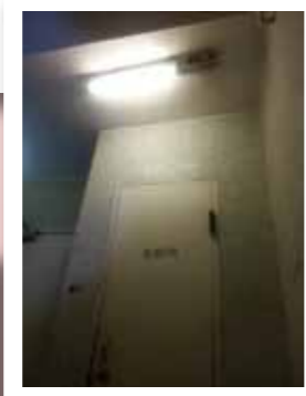
各座後樓梯更換T5光管 2013
