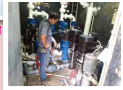
全苑安裝沖廁水泵 2012
