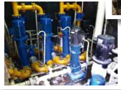
第1-9座更換公用食水供水喉 2011
