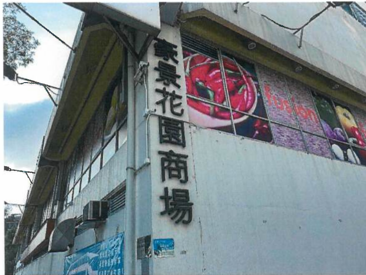
PR24103 Hongkong Garden Site Photos
